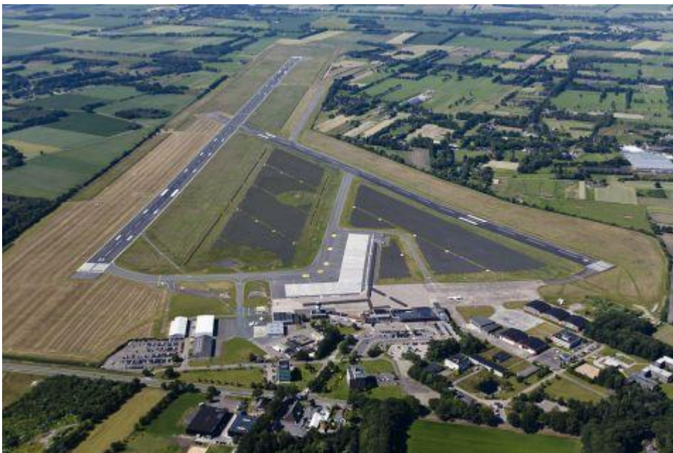
Afbeelding 2: Zonnepark Groningen Airport Eelde 3
