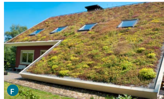
F In het lager gelegen gebied kiezen we voor langer vasthouden (o.a. vegetatiedaken) en vertraagd afvoeren naar retentiegebied
